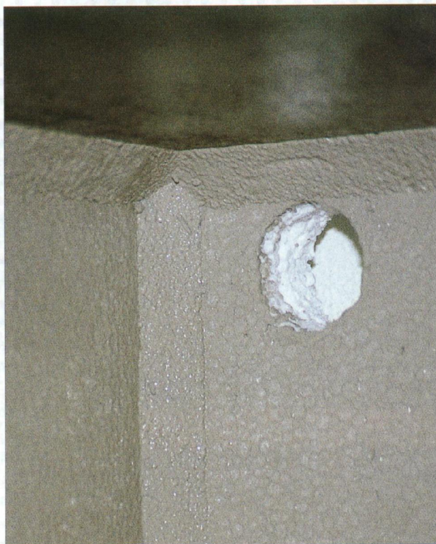
Rohbau, von innen gestrichen und mit kreisförmiger Entlüftung in der Rückwand
